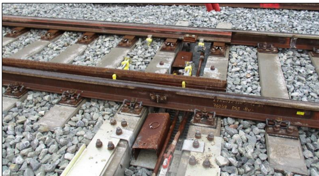
Billedet viser placering af låsebolte.
