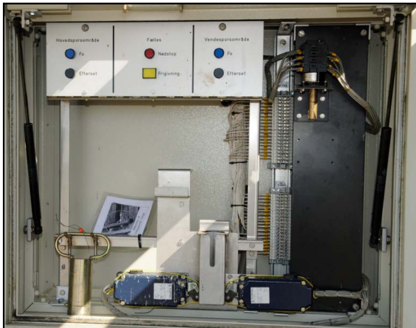
Skab med nødpanel type DSB 1990
