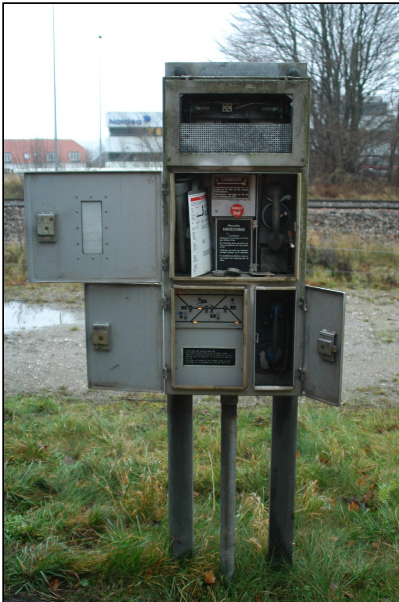
Betjeningsskab type DSB 1953, 1953/54, 1954, 1972, åbent
