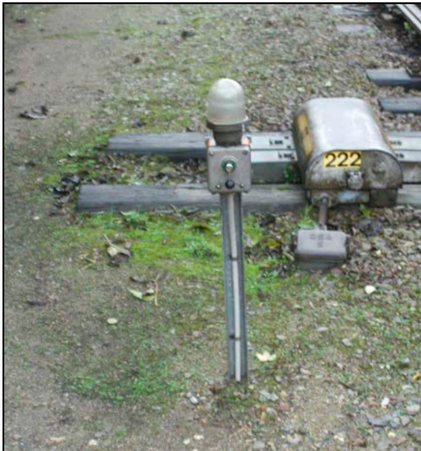
Centralaflåst sporskifte med el-stedbetjening
