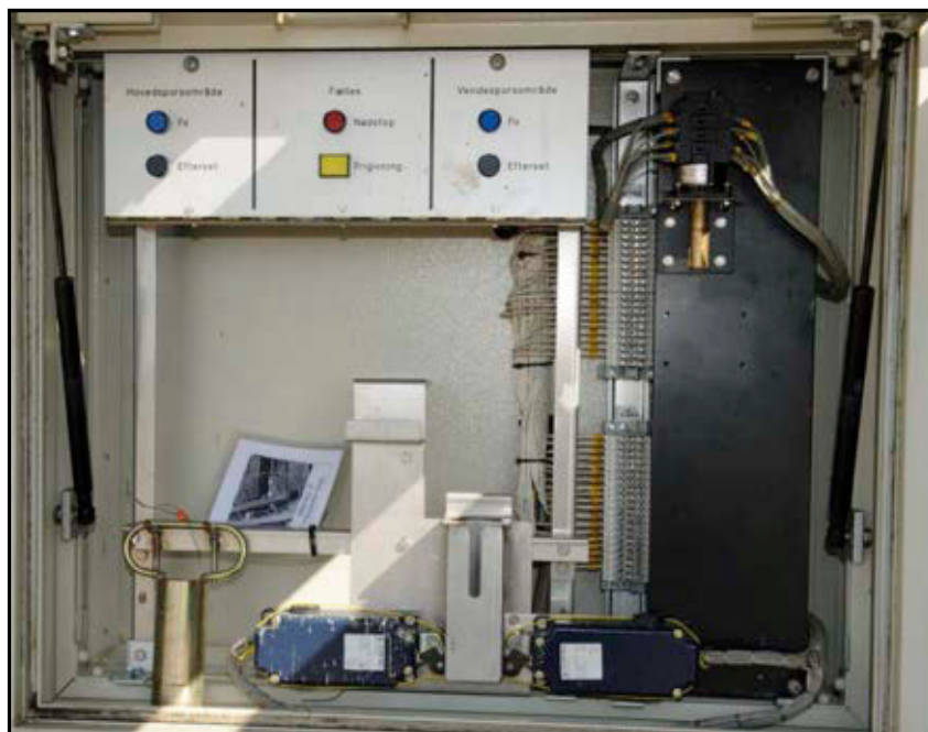
Skab med nødpanel type DSB 1990
