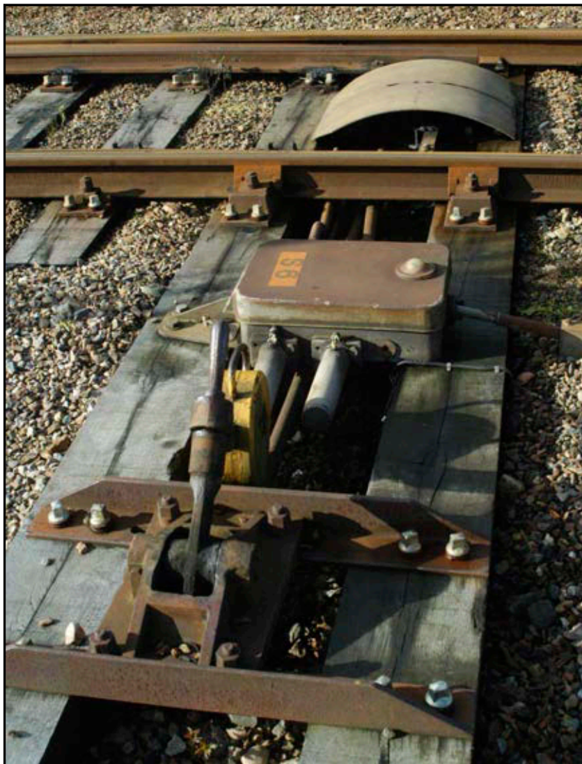
Centralaflåst sporskifte med magnetlås
