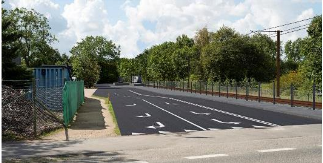
Figur 183. Fremtidige forhold set mod sydvest fra Nordmarksvej (Fotostandpunkt 30).
