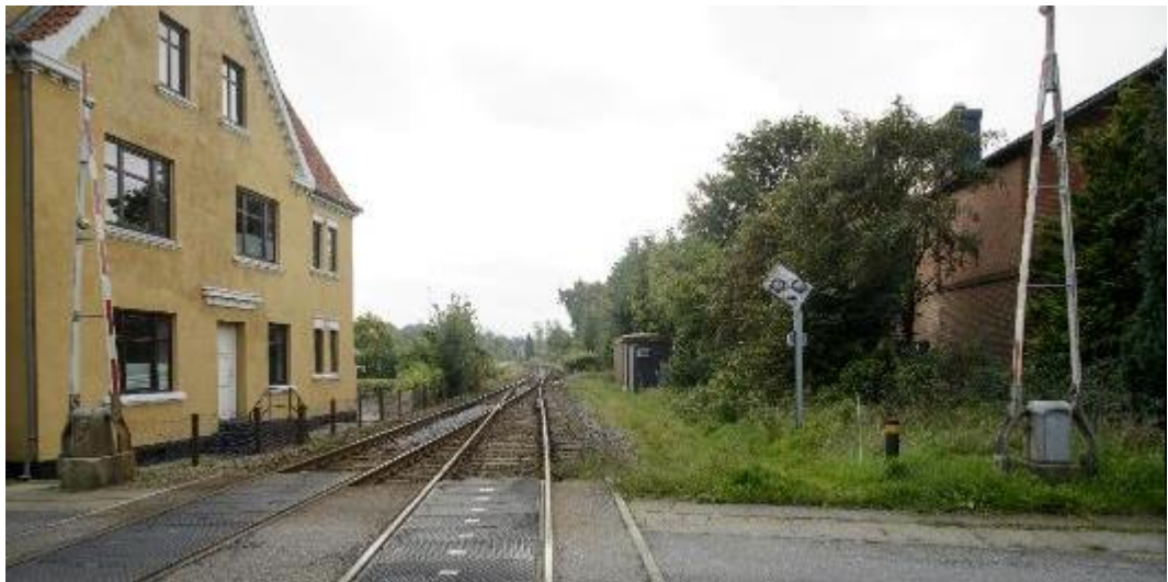
Figur 131. Eksisterende forhold set mod øst fra Langgade i Gadbjerg (Fotostandpunkt 14).
