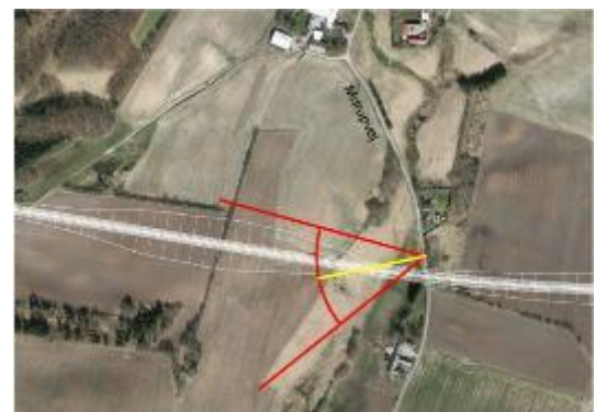
Figur 108. Fotostandpunkt 7 ved Mørupvej og banens st. 10+850.
