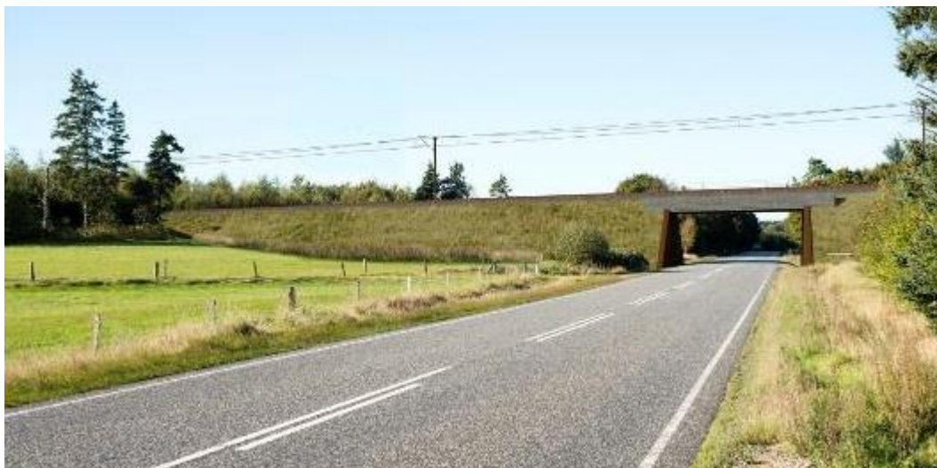
Figur 143. Fremtidige forhold set mod nordvest ad Tykhøjvej (Fotostandpunkt 17).
