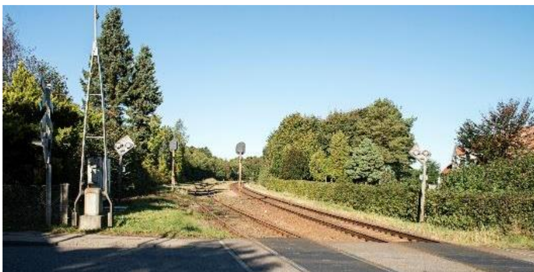
Figur 134. Eksisterende forhold set mod vest fra Langgade i Gadbjerg (Fotostandpunkt 15).
