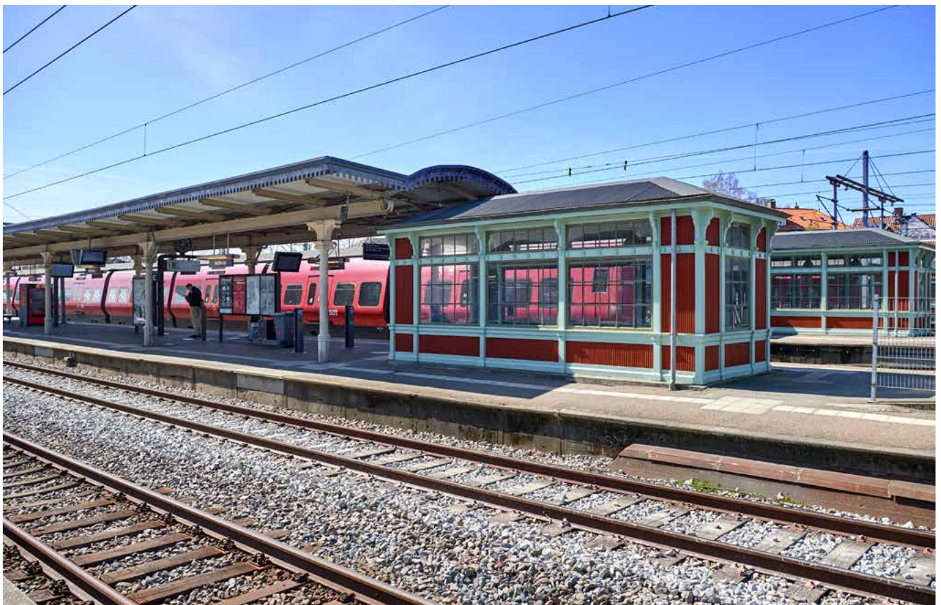
Billedet viser Hellerup Station. Sporene i forgrunden er de nuværende fjernbanespor. I løsning 2 er det muligt at opretholde regionaltogsbetjening til Hellerup. Nord for Hellerup tilsluttes S-togssporene de nuværende fjernbanespor.
