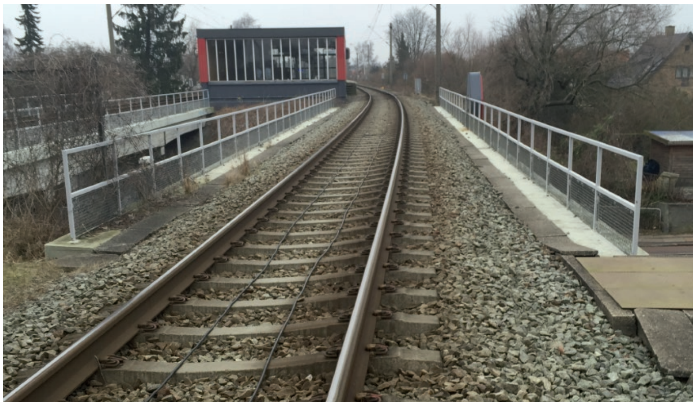
Eksempel på knast hvor overhøjde skal justeres, sporet sideflyttes og perron justeres, så der kan køres hurtigere gennem svinget.
