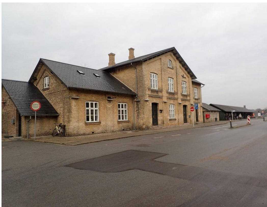
Figur 5: Skørping Station fra 1869. Stationsbygningen er fredet
