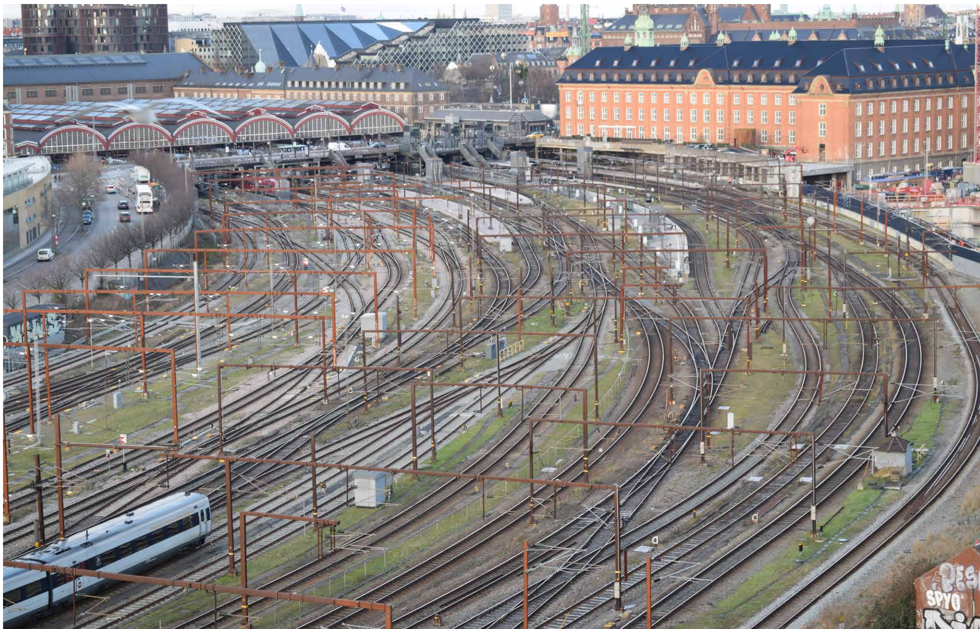
Figur 8: København H set fra syd. Overvejende del af fjernbanesporene på billedet fornyes og får en forbedret geometri ifm. ombygning til driftsseparation.
