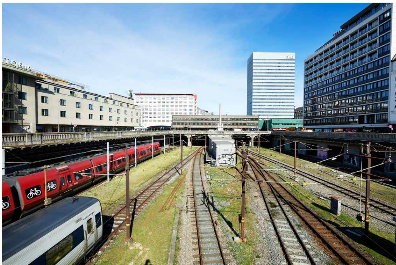
Figur 22. "Røret" i banegraven nord for København H.
