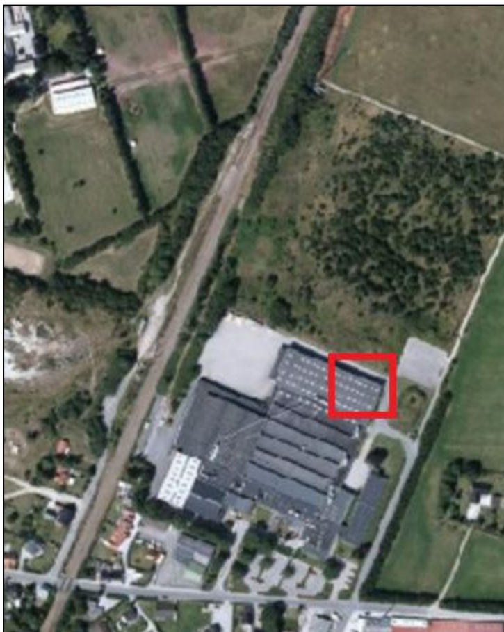
Figur 24. Orthofoto fra 2014 /5/, hvoraf det fremgår at søen, der ses på luftfoto fra 1945 (Figur 30) ikke længere er eksisterende. Randers Kommune.
