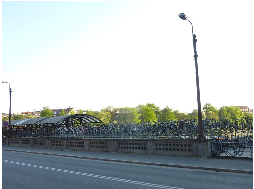
Figur 2 Eksisterende forhold på Bruuns Bro med cykelparkering, samt udsyn ud over banegraven fra view 1.
