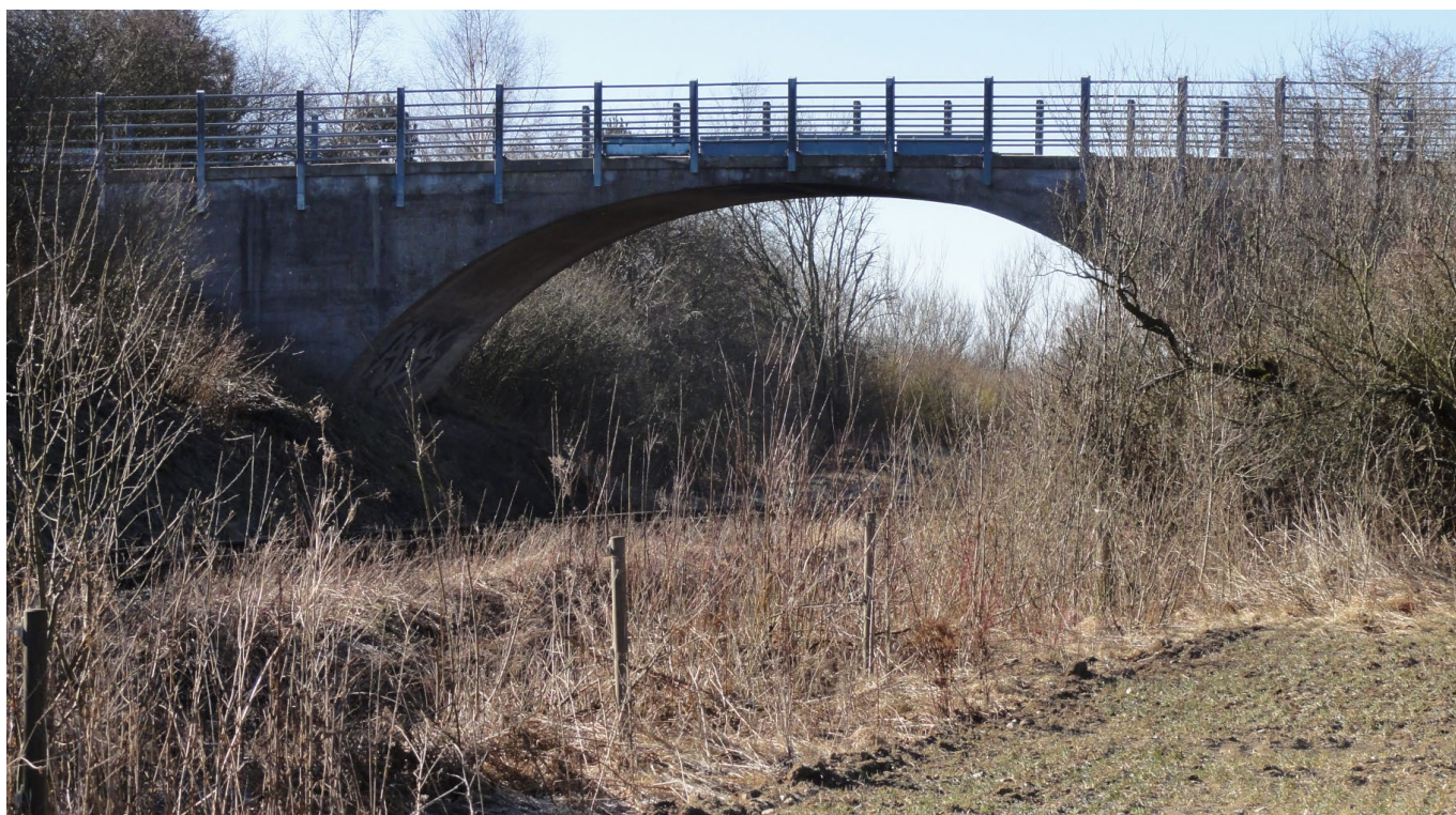
På strækningen er der flere af denne type broer, som muligvis er for lave til, at der kan placeres køreledninger under dem
